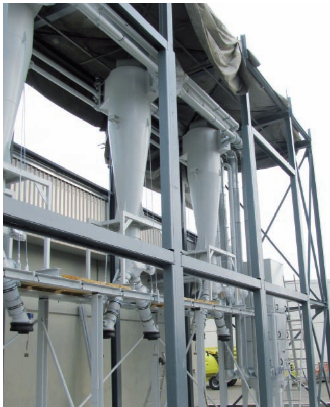
图3：Getecha采用正压输送和负压抽吸输送两种方式实现粉碎物料的输送
