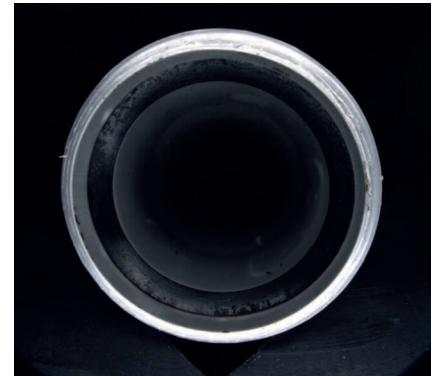
Die Dichtung wurde korrekt positioniert
