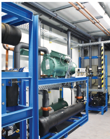
Neue Kältetechnik ersetzt altes R22-System: Die Schraubenverdichter-Anlage mit Vario-Technologie und R513A hat Vorteile für das Unternehmen und die Umwelt
